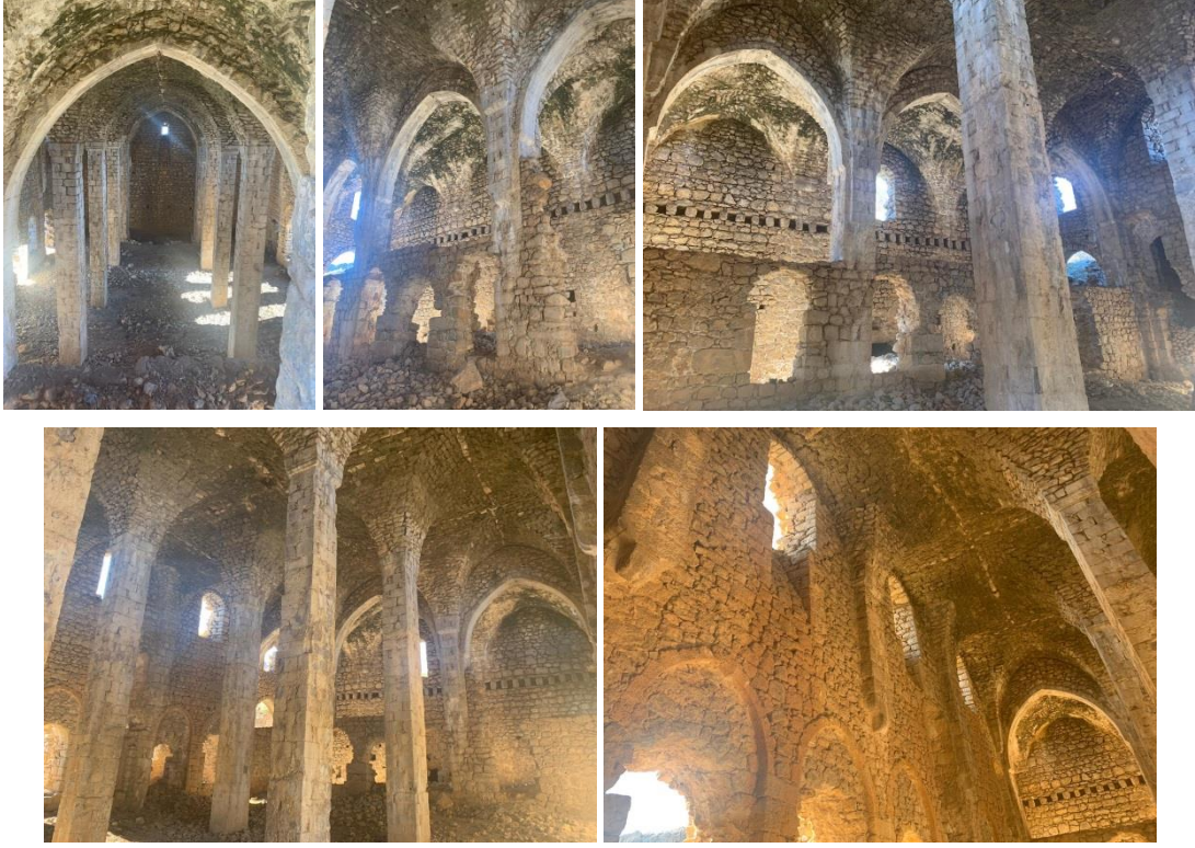
Şekil 9. Surp Garabed Manastırı cephe görünümü ve üst örtü (2021)
