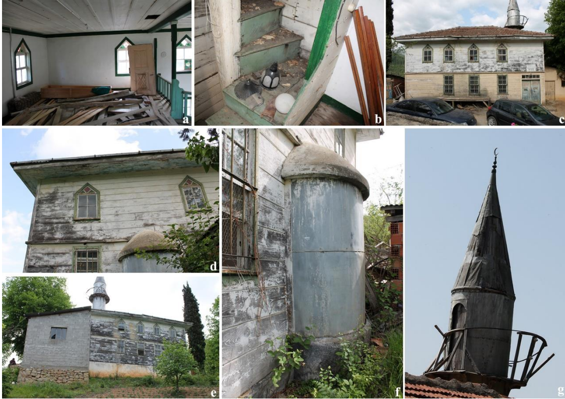
Şekil 3. Cami Üst Kat Mekânları ve Yapım Sistemi
