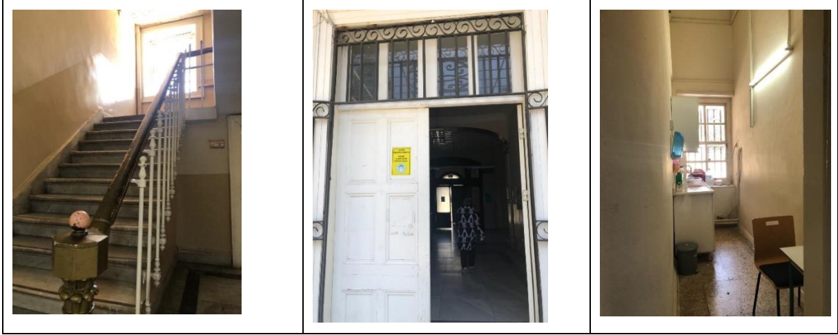
Görsel 11. Baltacı Köşkü İç Mekan Görünümleri, Giriş Holü. Kaynak: Yazar arşivi, 2023.
