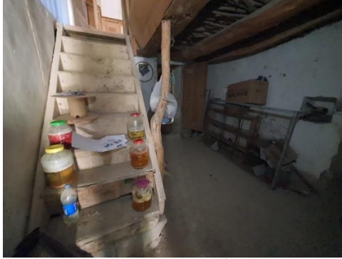
Fotoğraf 10. Sofadan (Z03) İç Mekan, Ahşap Merdivenler, Yazar Arşivi
