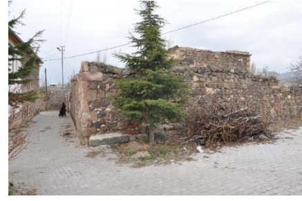
Fotoğraf 4. Yapının Sokak Üzerinden Girişindeki Yol, Yazar Arşivi
