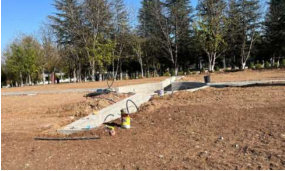
Şekil 12. Havuz ve Kanalların İnşa Süreci
