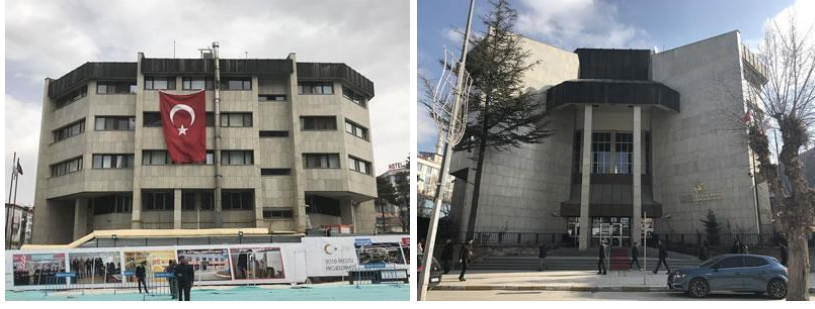
Resim 3. T.C. Merkez Bankası Van şube binası doğu (ön) ve güney cephesi (Gülen, 2020)
