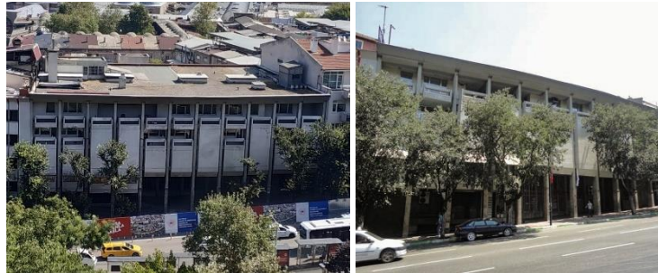
Resim 1. T.C. Merkez Bankası Bursa şube binası (URL 1; URL 2)
